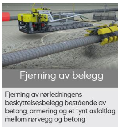
Figur 4 Illustrasjon over forberedelse på Kvitebjørn gassrørledning (KGP)
