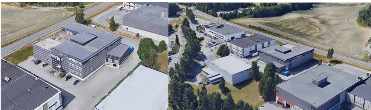
Figur 1 Foto av bygget og området
